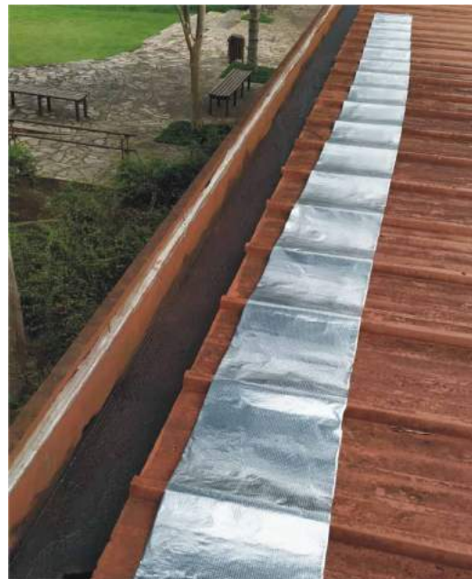
Impermeabilização do telhado
