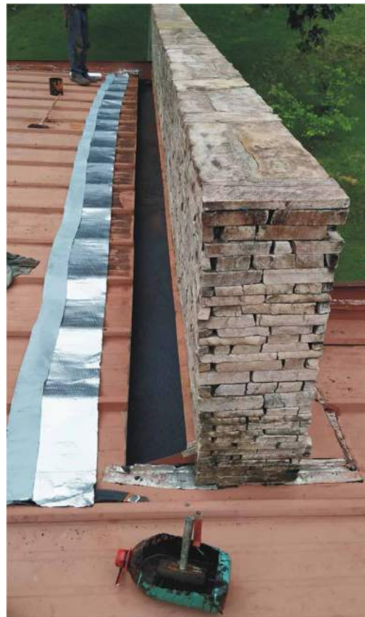
Trabalho de impermeabilização do telhado do Centro de Memória
